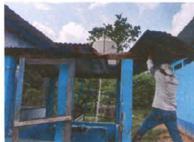
Foto 4: Sustitución de estructura de soporte de madera por metal en el área de la pila
