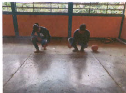
Foto 2: Sustición de piso de cemento liquido por piso de grantio en el aula de Tercero y Cuarto Grado
