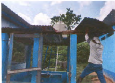
Foto1: Sustición de lámina troquelada aluzinc calibre 26 en área de la pila
